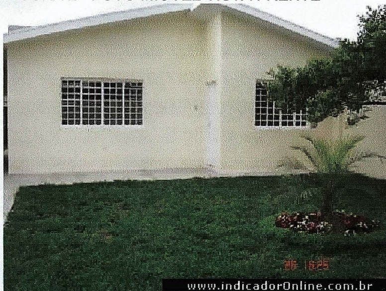
FIGURA 2 - FOTO IMÓVEL VISTA FRENTE
