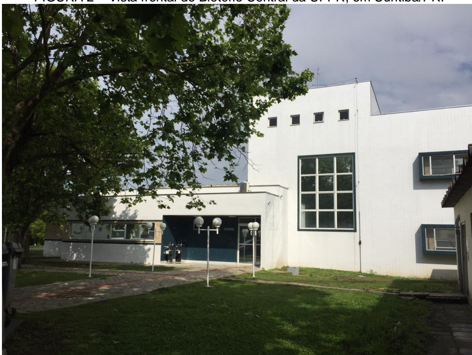
FIGURA 2 – Vista frontal do Biotério Central da UFPR, em Curitiba/PR.
