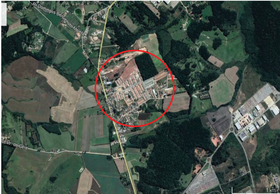
Figura 21 – Residencial Dom Felipe, Campo Largo da Roseira, SJP
