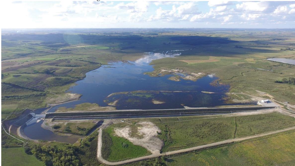
FIGURA 15. – Vista aérea da barragem
