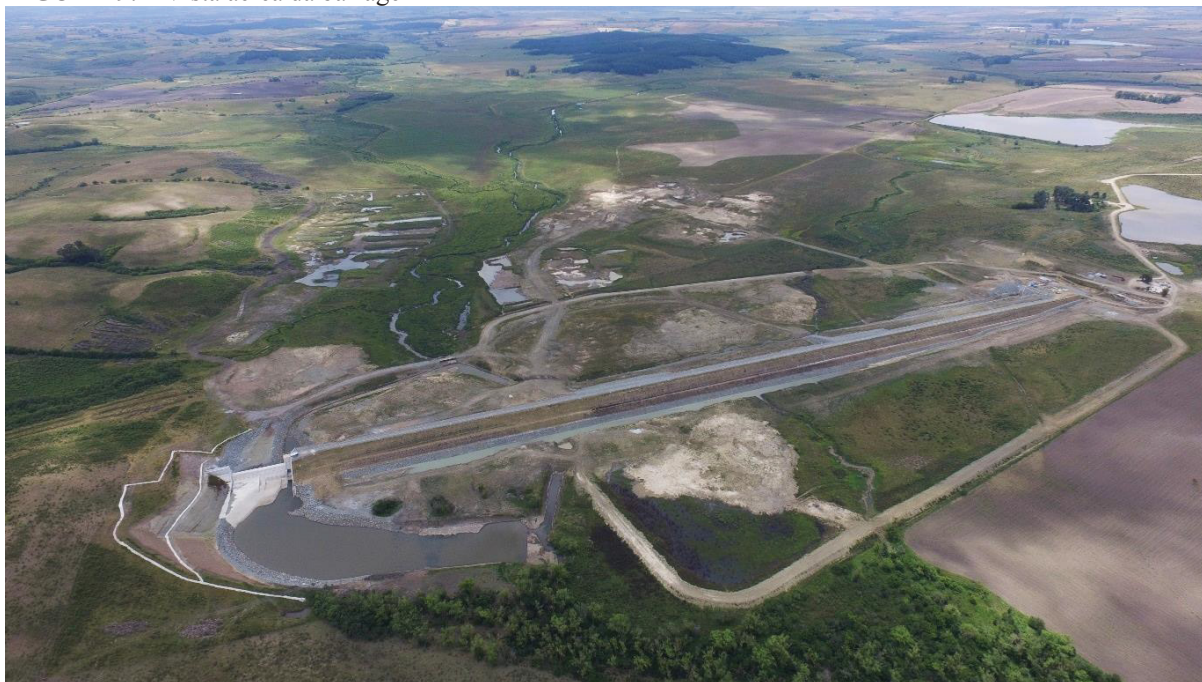
FIGURA 9. – Vista aérea da barragem
