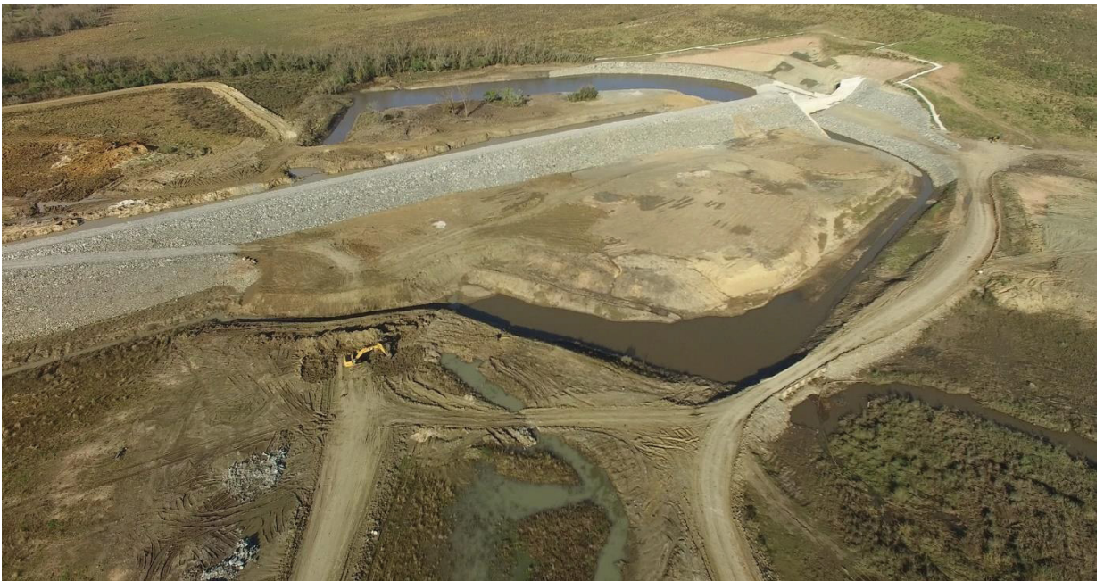
FIGURA 3. vista aérea da barragem
