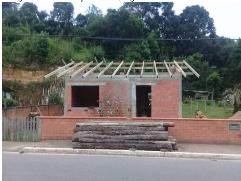
Figura 05 – Construção Imóvel programa minha casa minha vida
