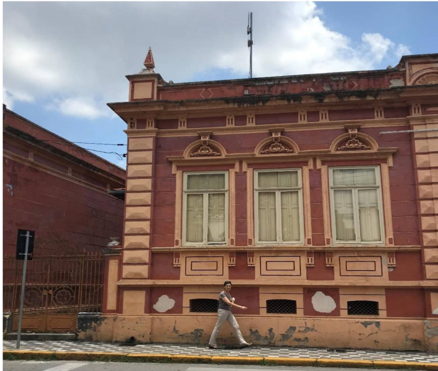
FIGURA 18 - EDIFÍCIO SEM UTILIZAÇÃO.
