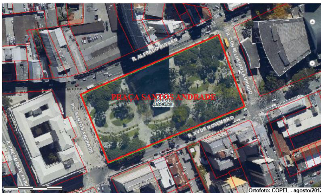
Figura 20 – Vista aérea da Praça Santos Andrade, de Curitiba-PR. Fonte: COPEL, 2012.
