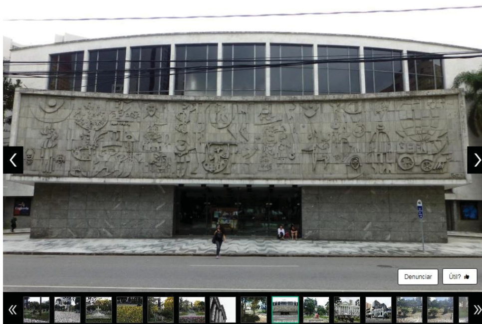
Figura 23 – Vista da fachada do Teatro Guaíra, localizado na praça, no lado oposto à UFPR. Curitiba-PR, por “NortonG”, (dez. 2015). Fonte: TripAdvisor , 2017.
