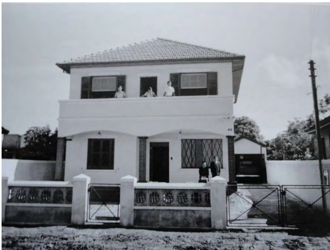
FOTO 45 - SOBRADO RECÉM-CONSTRUÍDO, RUA SÃO JERÔNIMO, 1950 – LONDRINA/PR. FONTE: BURGI. Haruo Ohara. Fotografias. I.M.S., 2008
