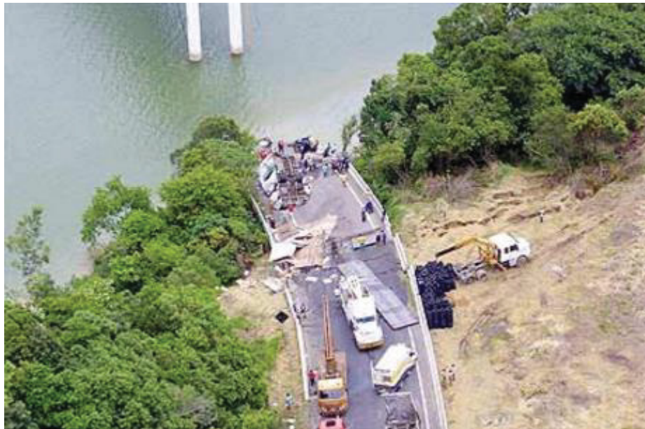
FIGURA 1-1– ACIDENTE NA PONTE SOBRE A REPRESA DO CAPIVARI-CACHOEIRA
