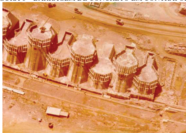
FIGURA 6 – BARRAGEM DE CONCRETO EM CONTRAFORTE
