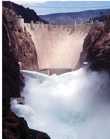
FIGURA 5 – BARRAGEM DE CONCRETO TIPO ARCO-GRAVIDADE
