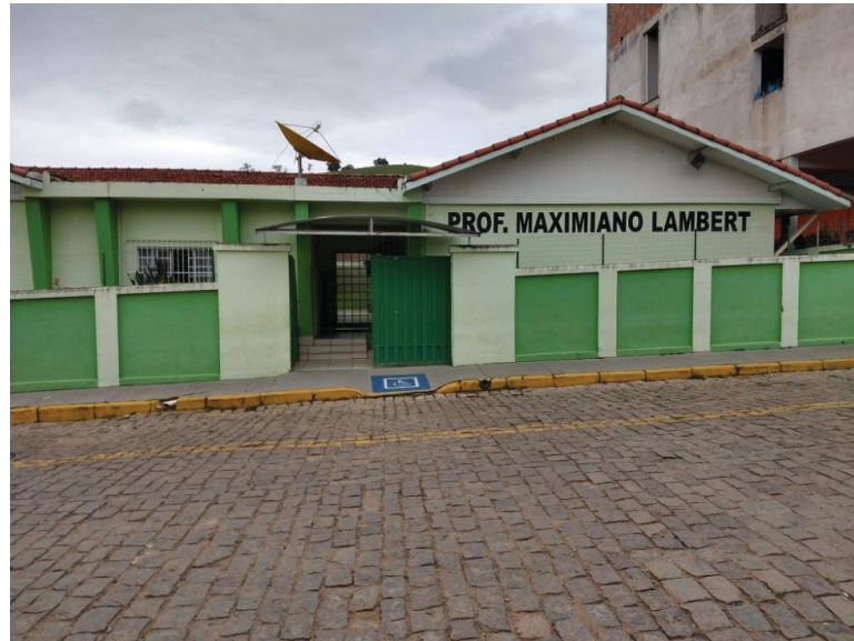
Figura 2: Vista frontal da E.E.P.M.L., localizada em Córrego do Bom Jesus - MG.
