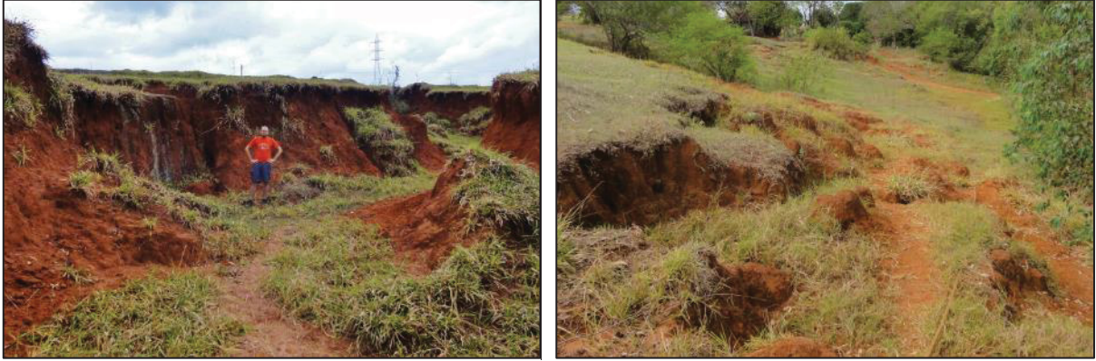
FOTOGRAFIA 2 – EROSÃO NA ZONA RURAL DE LOANDA
