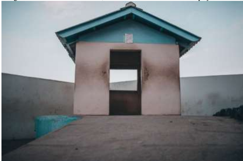
Imagem 16 - Casinha de brincar, construída em alvenaria no espaço externo do CEI.
