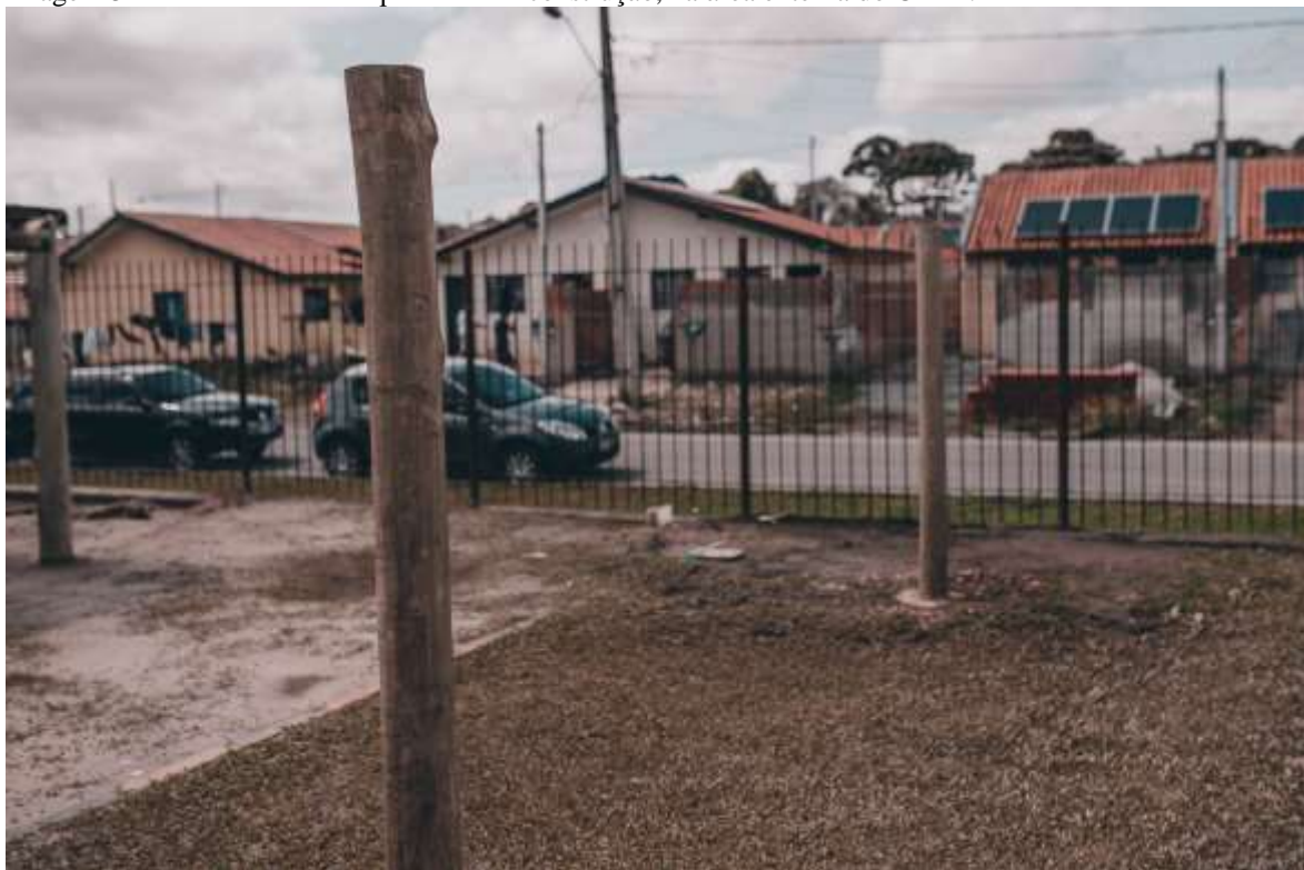
Imagem 5 - “Falsa Baiana” em processo de construção, na área externa do CMEI.
