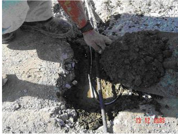
FIGURA 39 - COBERTURA DOS APARELHOS COM CONCRETO CONVENCIONAL FLUIDO
