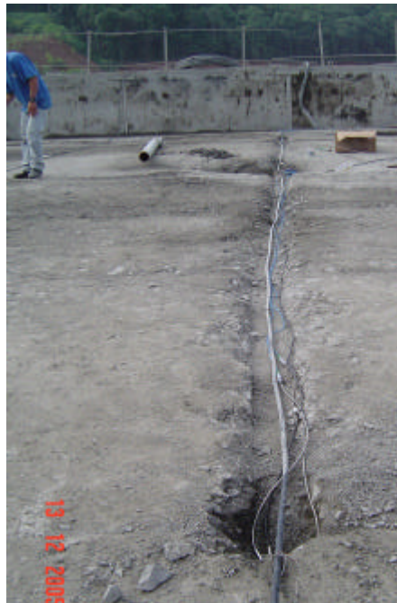
FIGURA 38 - COLOCAÇÃO DE SENSORES E CABOS TCVC: DESTACA-SE QUE NA MESMA CANALETA INSTALOU-SE TFOR E TFOB PARA COMPARAÇÃO
