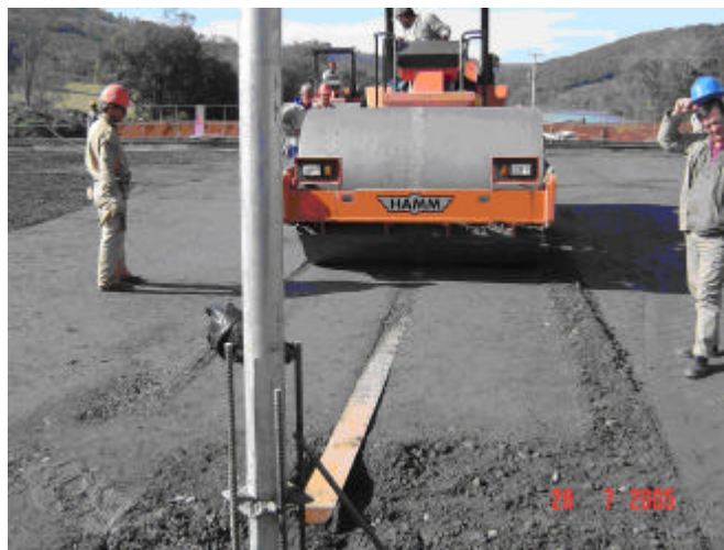
FIGURA 35 - COMPACTAÇÃO DA REGIÃO A SER INSTRUMENTADA - TCVC
