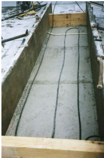
FIGURA 28 - DETALHE DA COLOCAÇÃO DOS CABOS NA CAMADA INFERIOR, BLOCO DE TESTES TFOR
