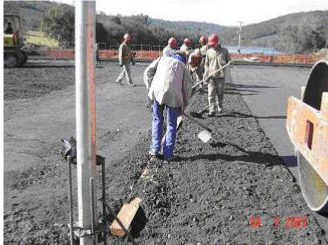
FIGURA 34 - COLOCAÇÃO DE FORMA DE BLOCKOUT ANTERIORMENTE À PASSAGEM DO ROLO - TCVC
