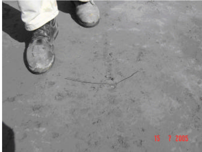
FIGURA 51 - SITUAÇÃO FINAL DO ARAME DE FIXAÇÃO DOS CABOS TFOR
