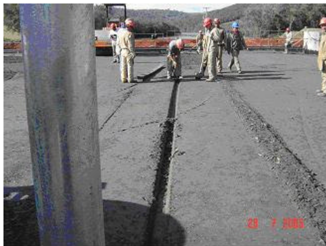
FIGURA 36 - RETIRADA DE FORMA DE BLOCKOUT APÓS A PASSAGEM DO ROLO - TCVC
