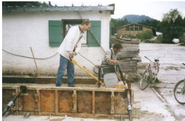
FIGURA 30 - DETALHE DO MÉTODO DE COMPACTAÇÃO DO CCR, BLOCO DE TESTES TFOR
