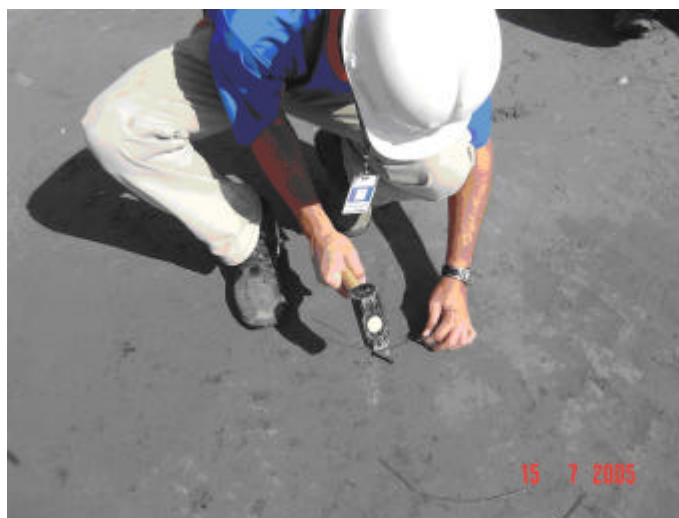
FIGURA 50 - CRAVAÇÃO FINAL DO PREGO COM O ARAME - TFOR
