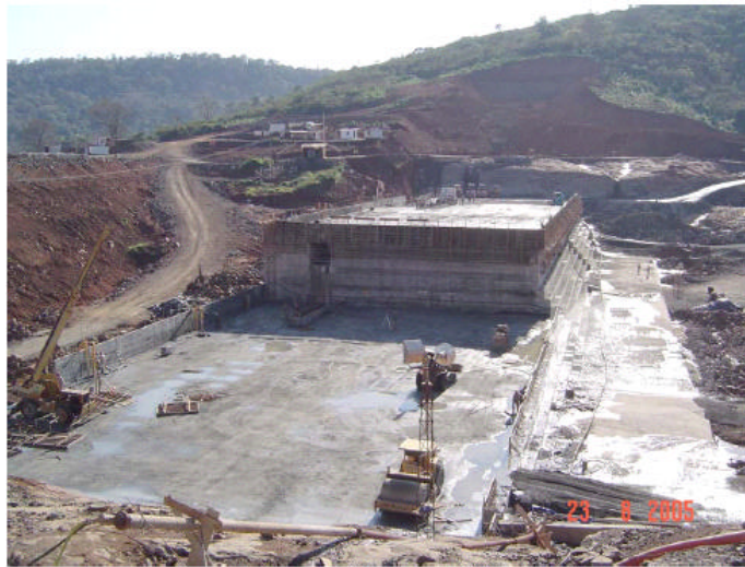
FIGURA 5 - VISTA GERAL DA BARRAGEM DURANTE A CONSTRUÇÃO
