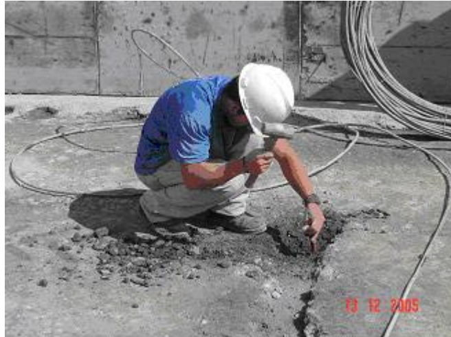
FIGURA 37 - ACABAMENTOS NOS LOCAIS ONDE SERÃO COLOCADOS OS SENSORES TCVC
