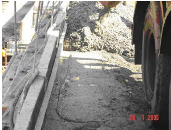
FIGURA 58 - APLICAÇÃO DE CCV DE FACE DE MONTANTE SOBRE O CABO DE FIBRA ÓTICA TFOR INSTALADO
