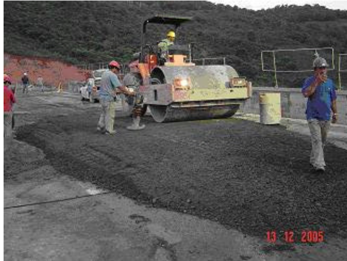
FIGURA 42 - COMPACTAÇÃO CUIDADOSA COM COMPACTADOR MANUAL SOBRE A REGIÃO INSTRUMENTADA TCVC: DESTACA-SE QUE O ROLO COMPACTA A REGIÃO ADJACENTE
