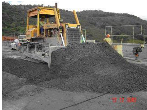
FIGURA 41 - LANÇAMENTO DE CCR SOBRE A REGIÃO INSTRUMENTADA - TCVC
