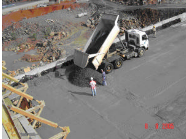
FIGURA 60 - DESCARGA DE CCR SOBRE O CABO DE FIBRA ÓTICA TFOR
