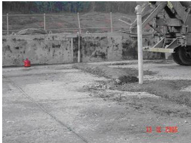
FIGURA 40 - PROTEÇÃO COM CONCRETO CONVENCIONAL DA REGIÃO INSTRUMENTADA - TCVC
