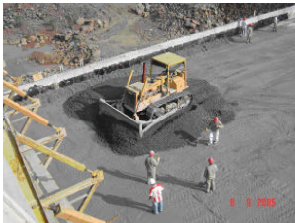
FIGURA 61 - ESPALHAMENTO DO CCR SOBRE O CABO DE FIBRA ÓTICA TFOR
