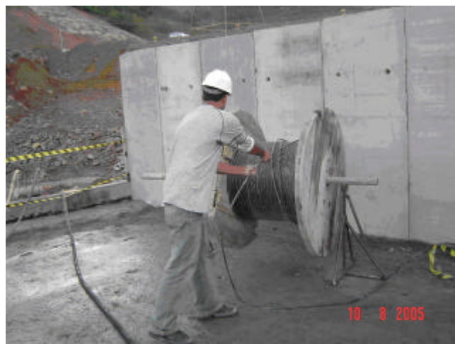
FIGURA 53 - ESTICAMENTO DOS CABOS TFOR A PARTIR DA BOBINA
