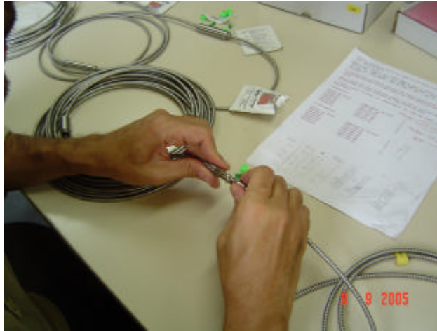
FIGURA 70 - DETALHE DAS EMENDAS DE CABOS TFOB, UTILIZANDO I-ÓPTICO
