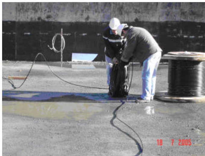
FIGURA 9 - TERMÔMETRO DE FIBRA ÓTICA PELO MÉTODO DISTRIBUÍDO TIPO RAMAN - TFOR, CABO PRETO ADQUIRIDO EM BOBINAS
