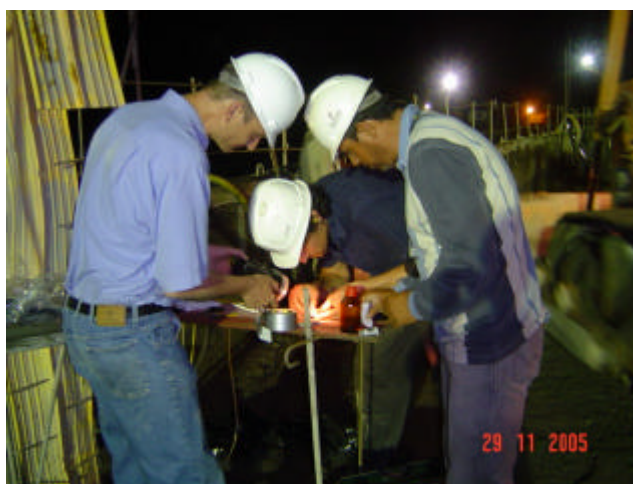
FIGURA 76 - EXECUÇÃO DA EMENDA DOS CABOS DE FIBRA ÓTICA TFOR
