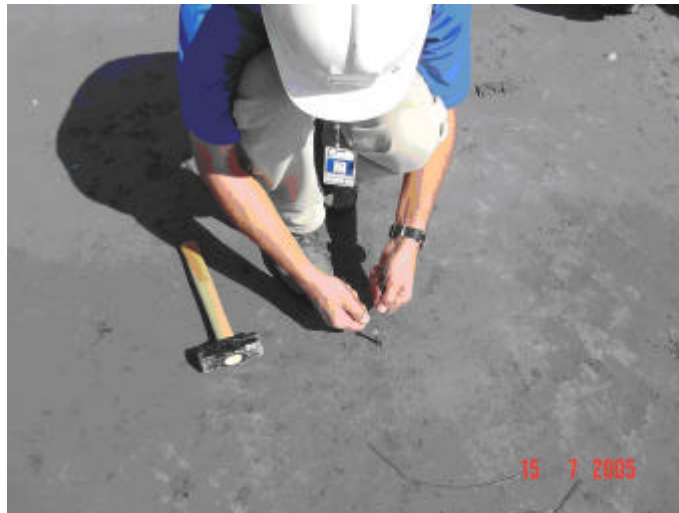
FIGURA 49 - FIXAÇÃO DE ARAME NO PREGO GUIA - TFOR
