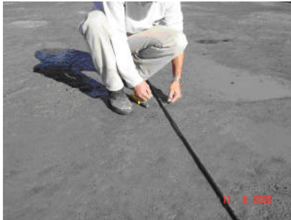
FIGURA 55 - FIXAÇÃO DOS CABOS DE FIBRA ÓTICA TFOR COM O ARAME PRESO AO PREGO GUIA
