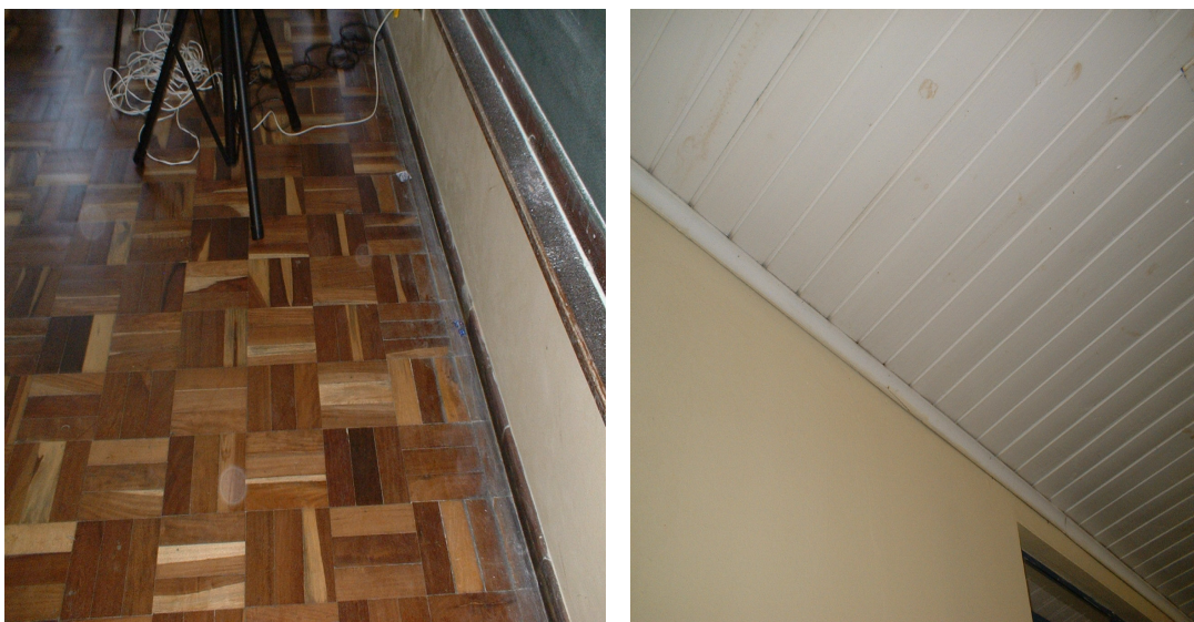
FIGURAS 30A E 30B – MATERIAL DO PISO E TETO DAS SALAS DE AULA (LUIZA ROSS)
