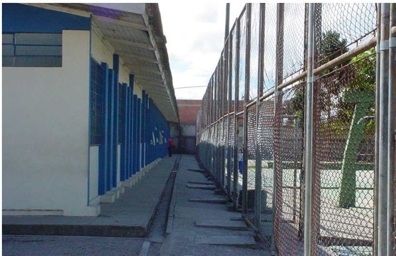
FIGURA 25 – PÁTIO DE EDUCAÇÃO FÍSICA LOCALIZADO PRÓXIMO AS SALAS DE AULA – ESCOLA LUIZA ROSS
