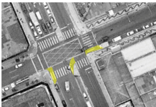
Figura 44 Cruzamento da Rua Visconde de Nácar com a Al. Dr. Carlos de Carvalho (vista aérea). Crédito: GoogleEarth.
