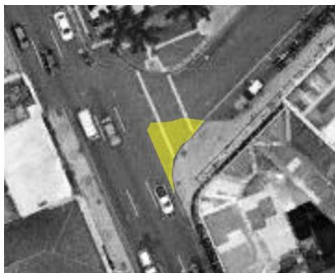
Figura 82 Encontro da Rua Cândido de Leão com a Alameda Doutor Muricy (vista aérea).
