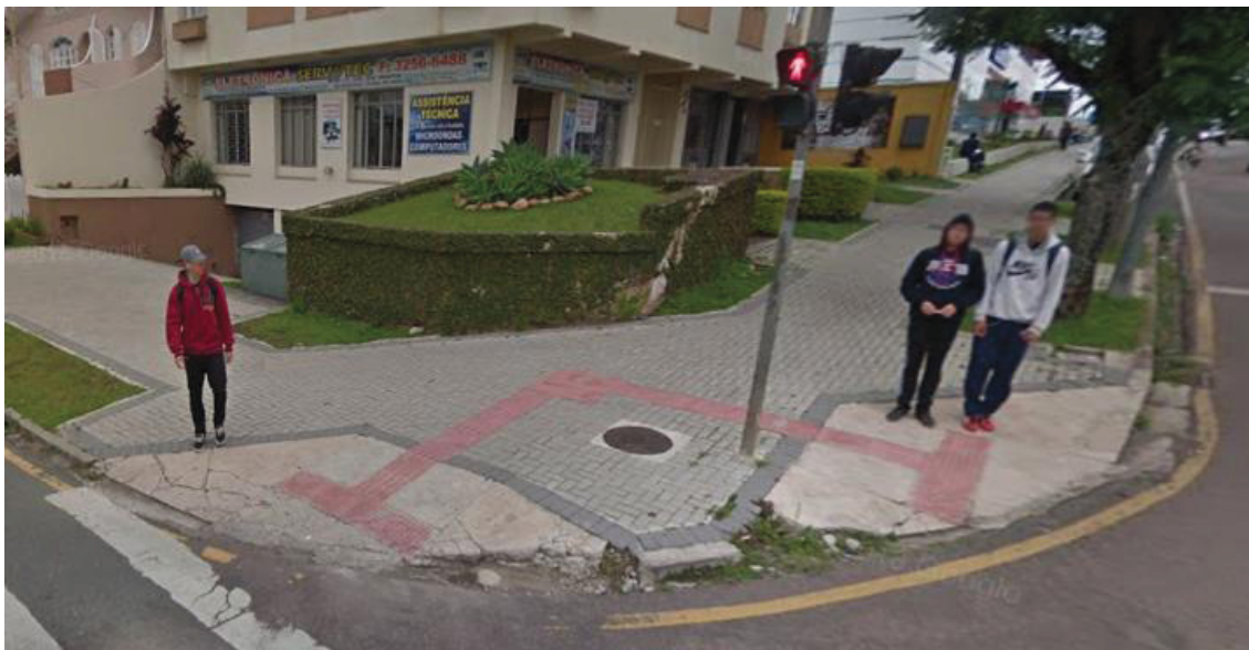
Figura 15 Rebaixamentos de calçada com problemas de conservação. Crédito: Google Street View.
