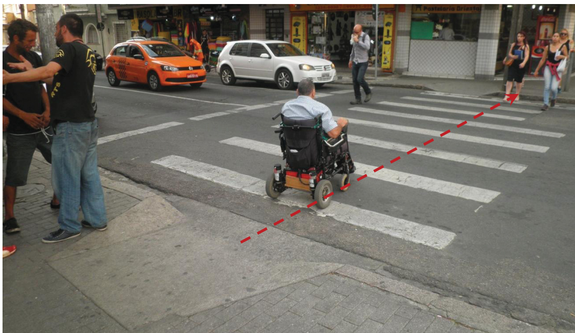
Figura 34. Cruzamento com rebaixamentos desencontrados (nota 0,5), na esquina da Al. Dr. Muricy com a Rua André de Barros.
