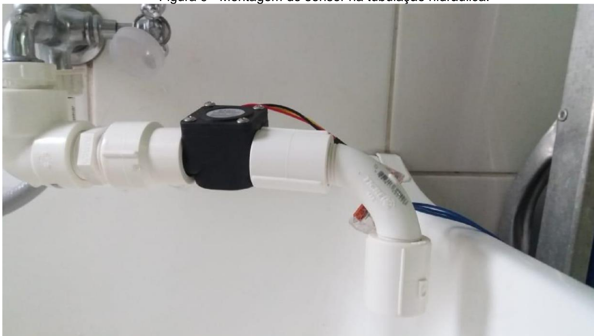
Figura 9 – Montagem do sensor na tubulação hidráulica.
