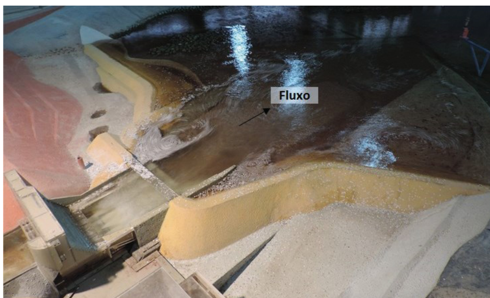
FIGURA 35 – Vista geral da região de jusante das estrutura de desvio de segunda fase do rio
