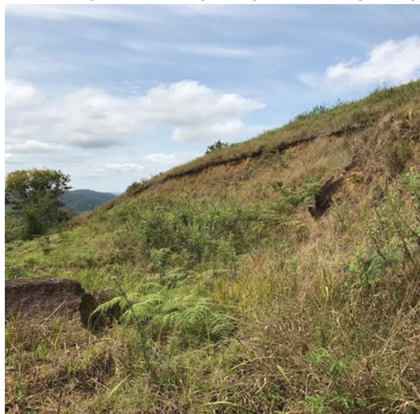
FIGURA 80 - DESLIZAMENTO PRETÉRITO À MONTANTE DO TALUDE KM 552+000 PN
