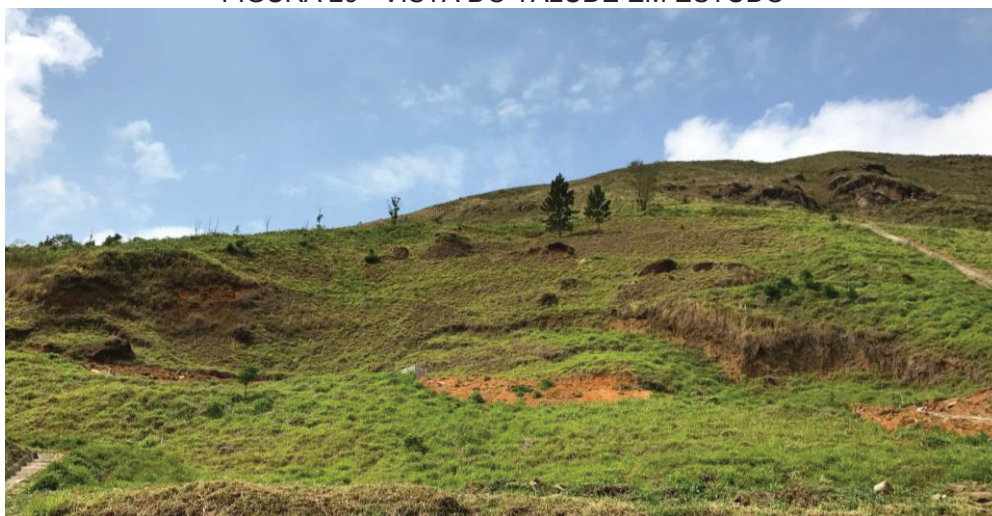
FIGURA 29 - VISTA DO TALUDE EM ESTUDO
