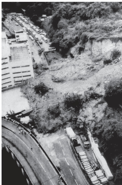
FIGURA 1 - DESLIZAMENTO NA RODOVIA FEI TSUI EM 13 DE AGOSTO DE 1995
