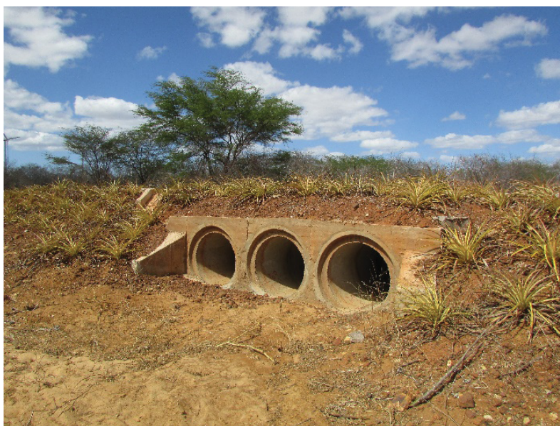
Figura 5: Estrutura monitorada durante monitoramento de processos erosivos. Fonte: EDPr 2018.
