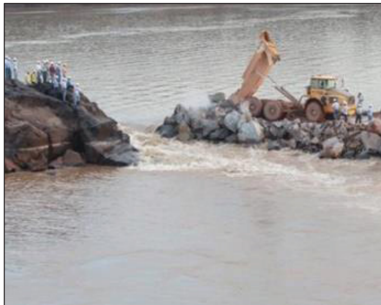
FIGURA 2.17 - FECHAMENTO DA BRECHA DO RIO MADEIRA FONTE: SANTO ANTÔNIO ENERGIA (2011)
