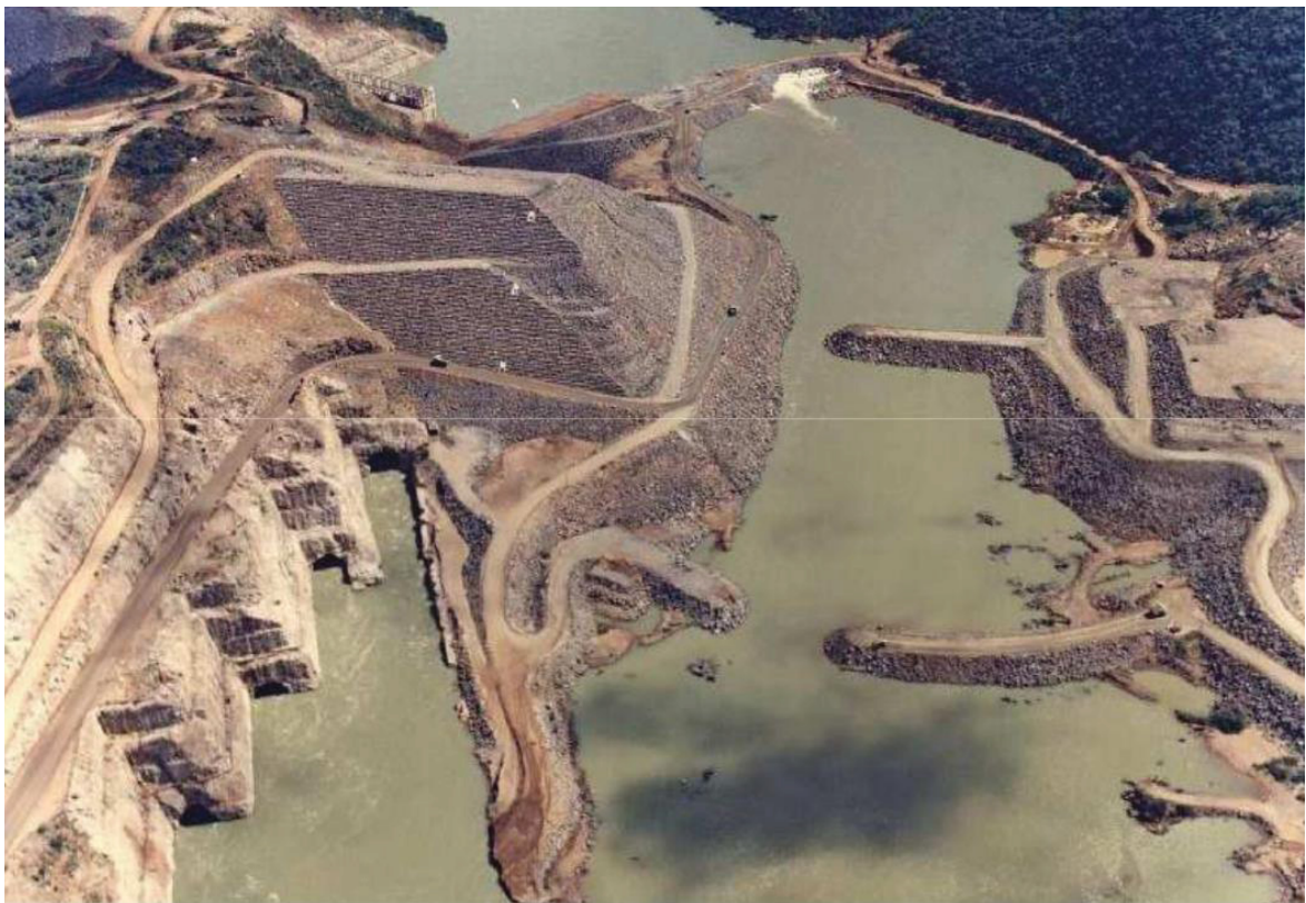
FIGURA 2.5 - SEGUNDA FASE DE DESVIO DO RIO XINGÓ – VISTA DE JUSANTE FONTE: CARVALHO (2011)
