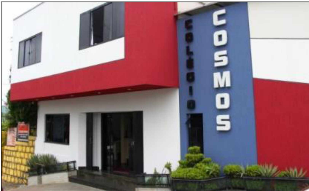
FIGURA 1 – FACHADA DO COLÉGIO
