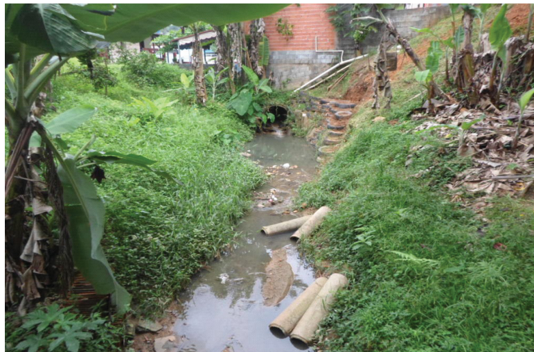
FIGURA 2 – DEMONSTRAÇÃO DE ESGOTAMENTO SANITÁRIO DESPEJADO EM CURSO D'ÁGUA NATURAL, COM NASCENTE PRESERVADA À MONTANTE, NO MUNICÍPIO DE BLUMENAU-SC
