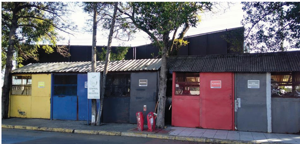
FOTOGRAFIA 2 – LOCAL DE ACONDICIONAMENTO DE RESÍDUOS SÓLIDOS
