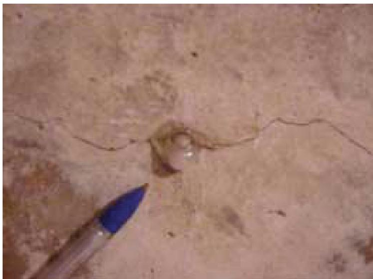
Figura 7: Detalhe de gel exsudando a partir da fissura na superfície do concreto (HASPARYK, 2005).
