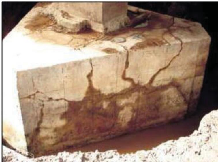
Figura 2: Fissuras em bloco de fundação afetado pela RAA na cidade Recife/PE.
