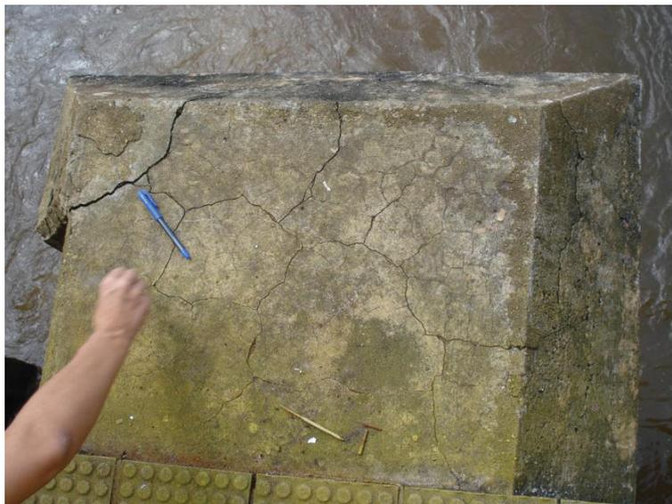
Figura 1: Exemplo de fissuração causada pela RAA - usina hidrelétrica de Peti (OLIVEIRA, 2013).
