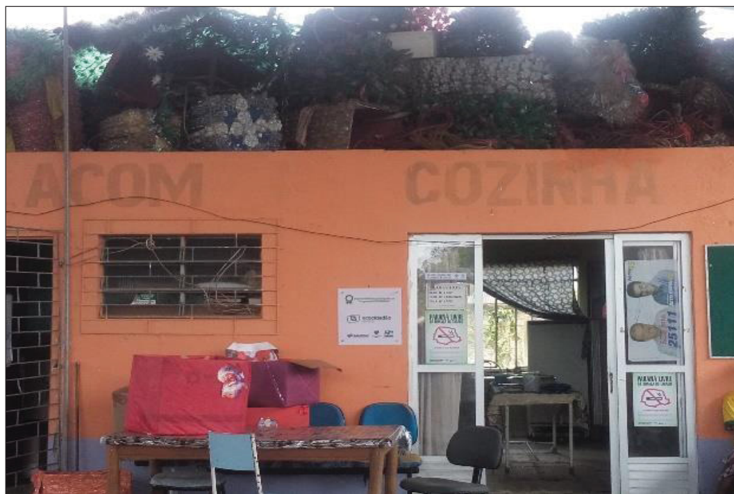
FIGURA 10: SEDE DA ASSOCIAÇÃO DE COLETORES DE MATERIAL REICLÁVEL PÔR DO SOL.
