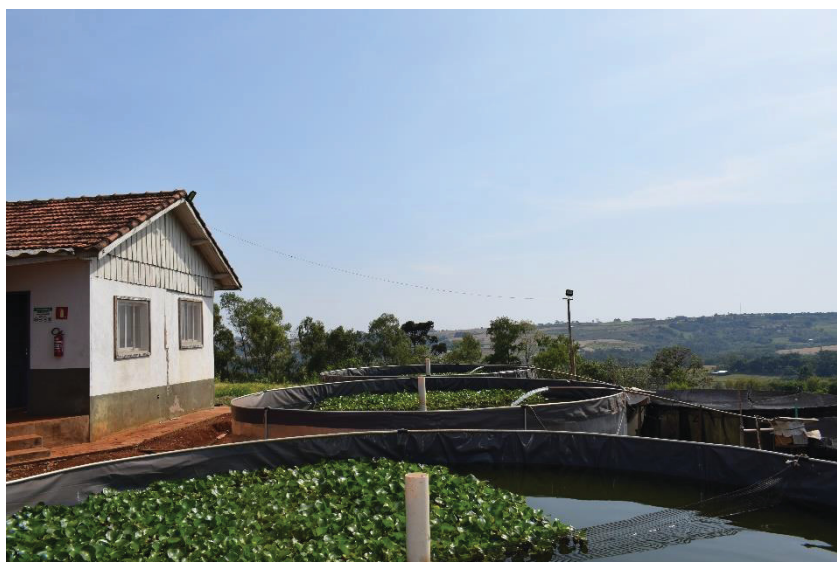
Figura 3. Tanques de biofiltro cobertos parcialmente por macrófitas responsável pela biofiltração.
