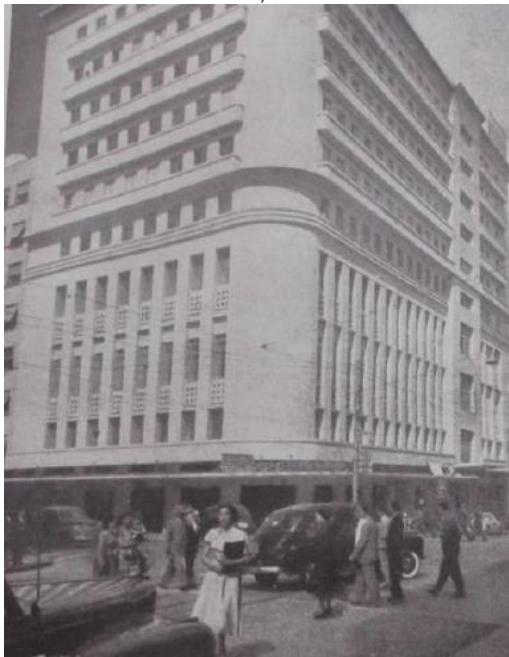
FIGURA 2 – CENTRO DE CURITIBA: CENTRO VIÁRIO DA ESQUINA DO CLUBE CURITIBANO, 1953.
