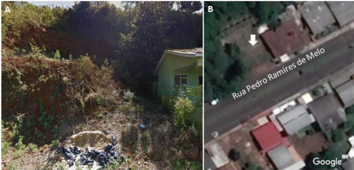
FIGURA 7.5 – EVIDÊNCIAS DE INSTABILIDADE NA ENCOSTA DA RUA PEDRO RAMIRES DE MELO
