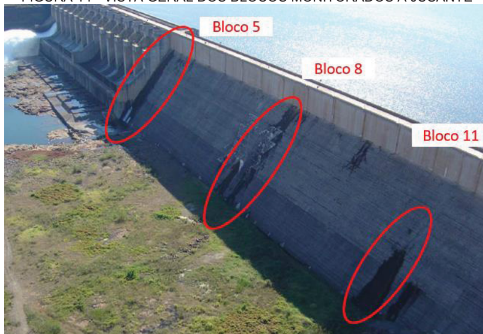
FIGURA 14 - VISTA GERAL DOS BLOCOS MONITORADOS A JUSANTE
