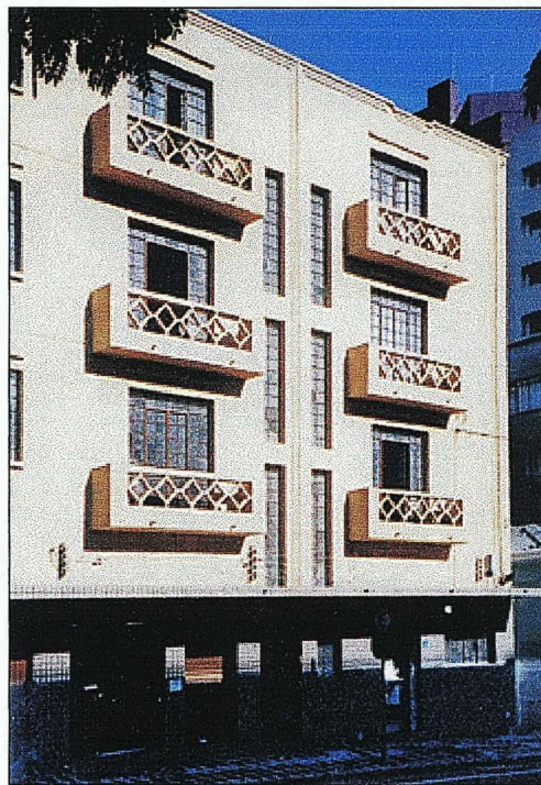
Figura 11: Edifício onde Arnaldo alugou um apartamento na rua Augusto Stelfeld nº 455.
