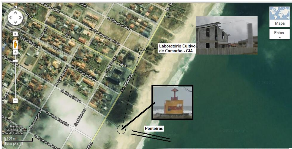
Figura 41 - Vista aérea da localização do laboratório de cultivo de camarão e da guarita do corpo de bombeiros (posto salva-vidas), onde fica o ponto de captação (ponto zero). Distância da ordem de 300 metros.
