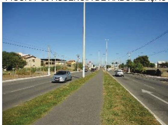
FIGURA- 36 AUSÊNCIA DE ARBORIZAÇÃO
