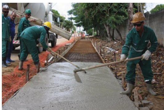
FIGURA 37 OBRAS DE SANEAMENTO
