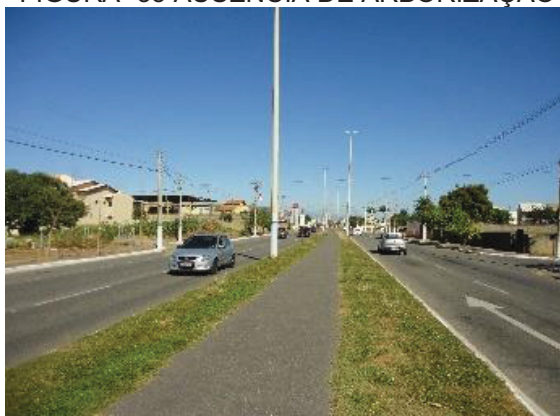
FIGURA -35 AUSÊNCIA DE ARBORIZAÇÃO
