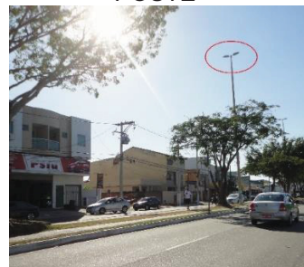
FIGURA- 33 LOCAÇÃO INADEQUADA DO PÓSTE
