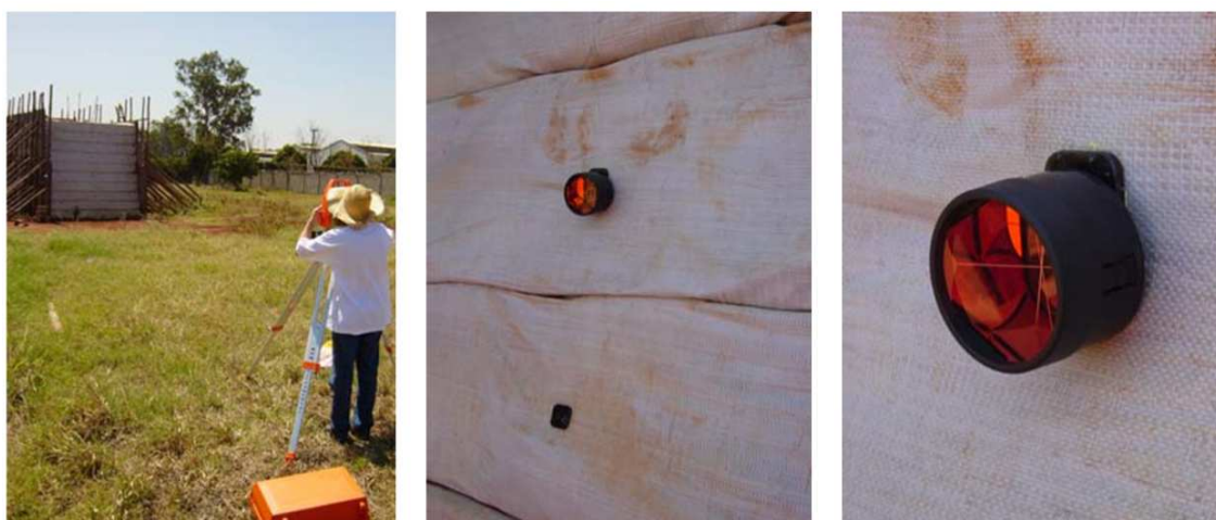
b) Equipamentos de topografia.
