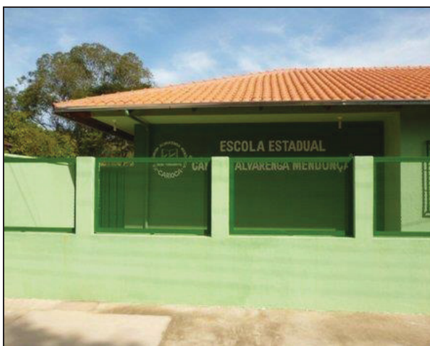
Foto 1: Vista da fachada da escola
