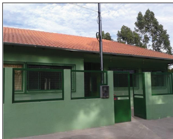
Foto 2: Vista da fachada da escola
