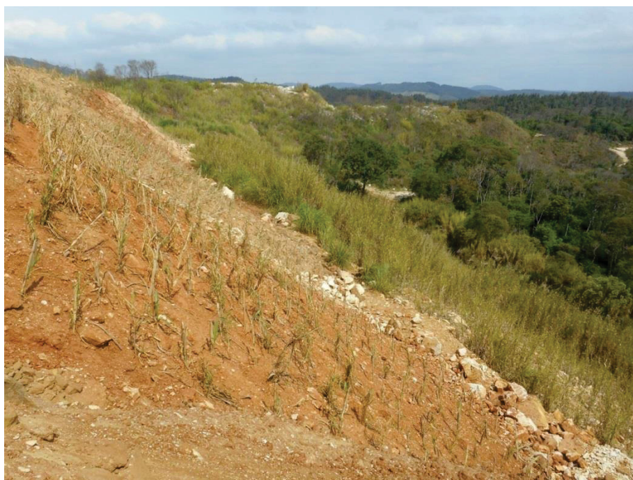
FIGURA 09 – Vista da Recuperação que está sendo feita pela empresa
