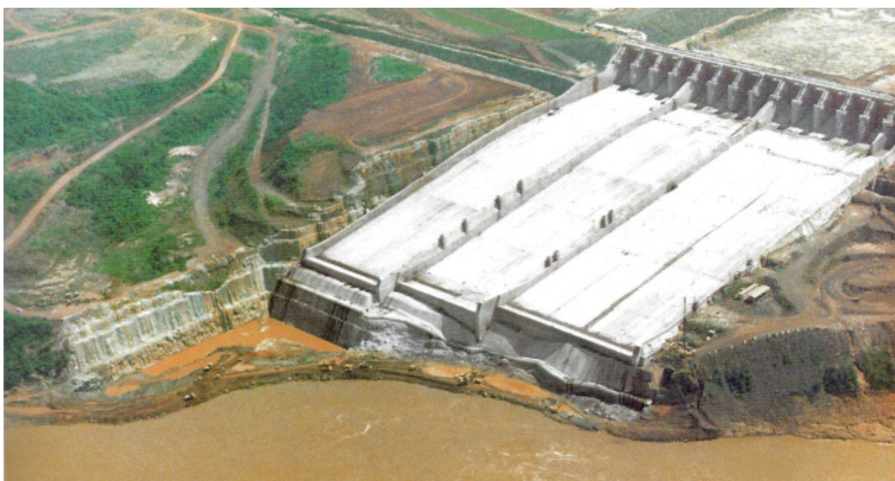
FIGURA 2.2 – VERTEDOURO DE ENCOSTA - UHE ITAIPU
