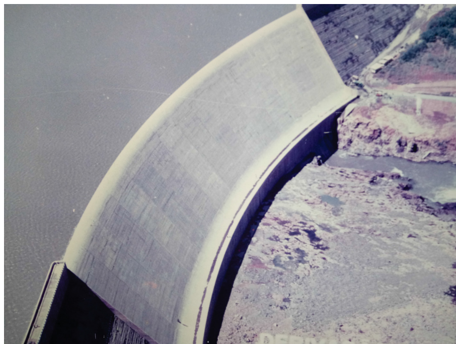
FIGURA 2.1 – VERTEDOURO DE SOLEIRA LIVRE - DERIVAÇÃO DO RIO JORDÃO
