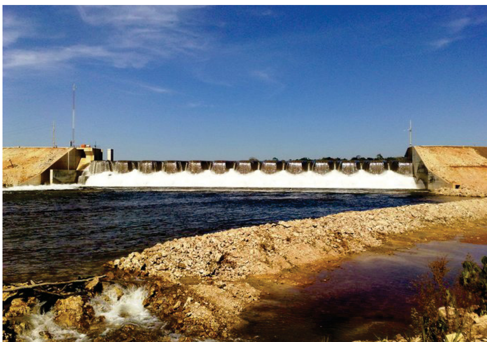
FIGURA 2.3 – VISTA FRONTAL DO VERTEDOIRO LABIRINTO DA PCH BOCAIUVA
