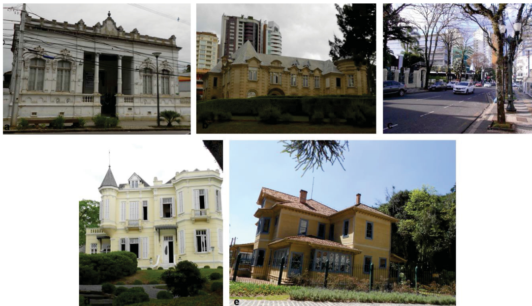
FIGURA 24 – BENS TOMBADOS NA UDH BATEL/BIGORRILHO: (a) ANTIGO GRUPO ESCOLAR CRUZ MACHADO; (b) CASTELO DO BATEL; (c) R. COMENDADOR ARAÚJO; (d) PALACETE DO BATEL; (e) CASA GOMM
