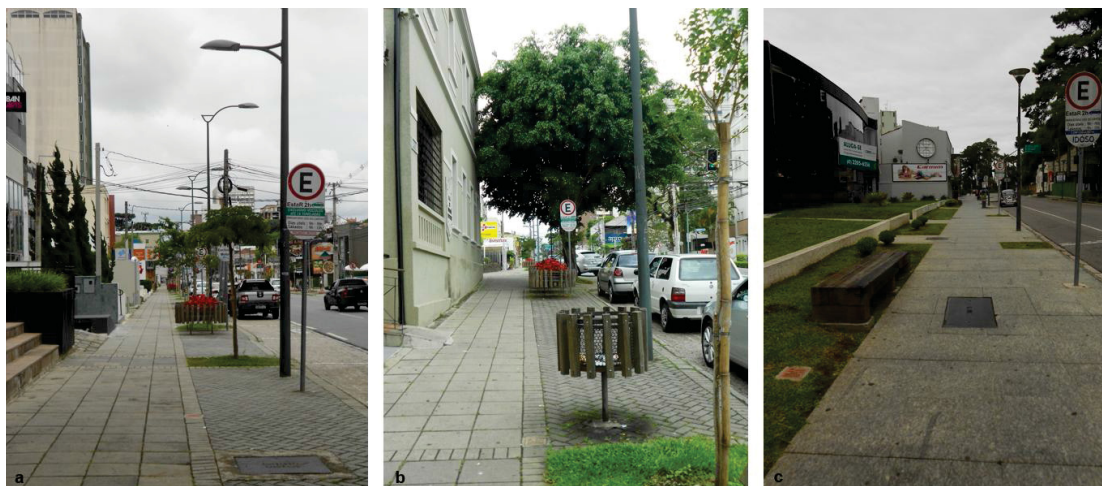
FIGURA 36 – CALÇADAS NA UDH BATEL/BIGORRILHO: (a); (b) PASSEIOS BEM CONSERVADOS; E (c) CALÇADA DE GRANITO NA AVENIDA DO BATEL
