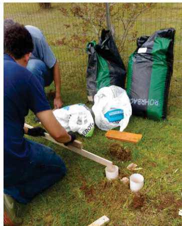
FIGURA 10 – MONTAGEM E NIVELAÇÃO DOS PÉS
