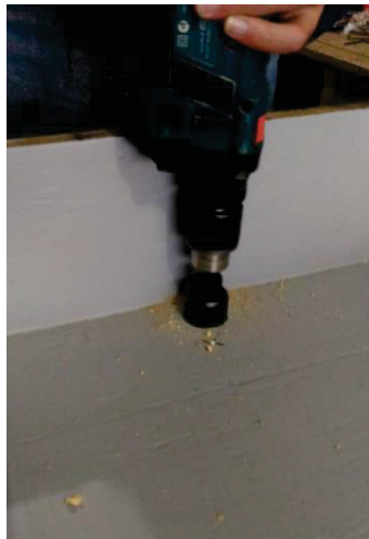
FIGURA 16 - FURAÇÃO DA CAIXA PARA POSTERIOR ENCAIXE DO TUBO DE QUEDA
