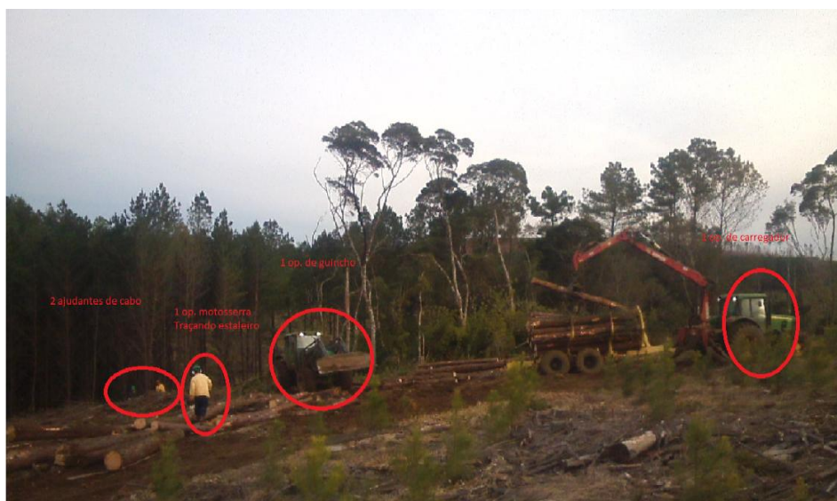
FIGURA 22 – OPERAÇÃO SEMI MECANIZADA
