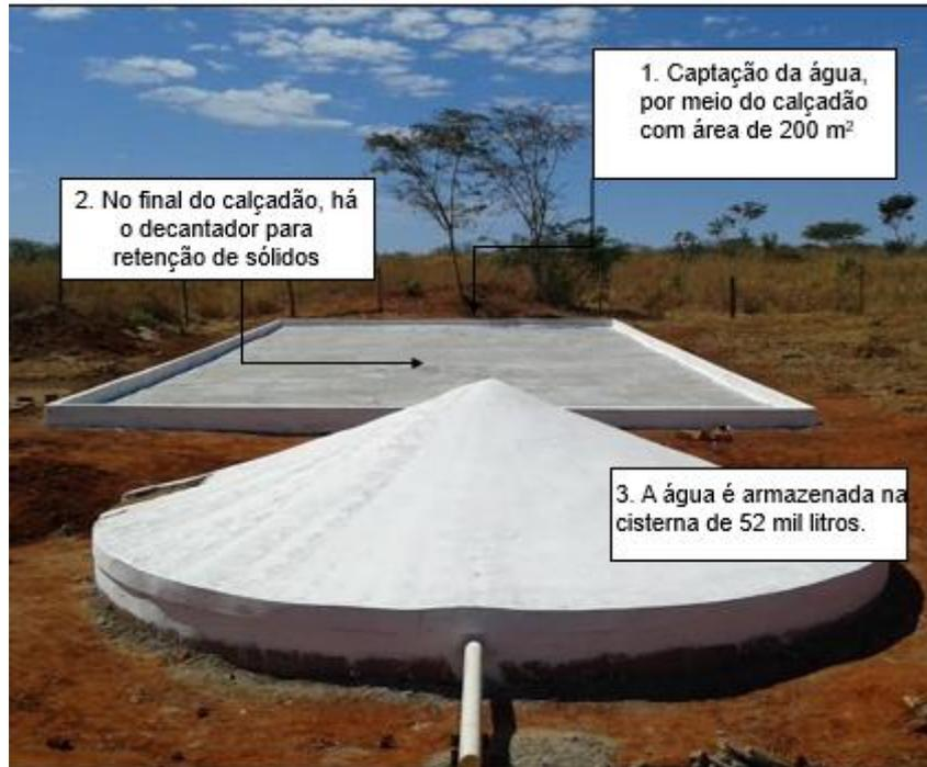
FIGURA 3 – ESQUEMA DE CAPTAÇÃO DA ÁGUA DA CHUVA POR UMA CISTERNA CALÇADÃO.
