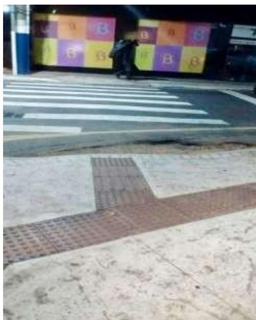
Figura 1: Rebaixamento da Calçada com Desnível da Via.
