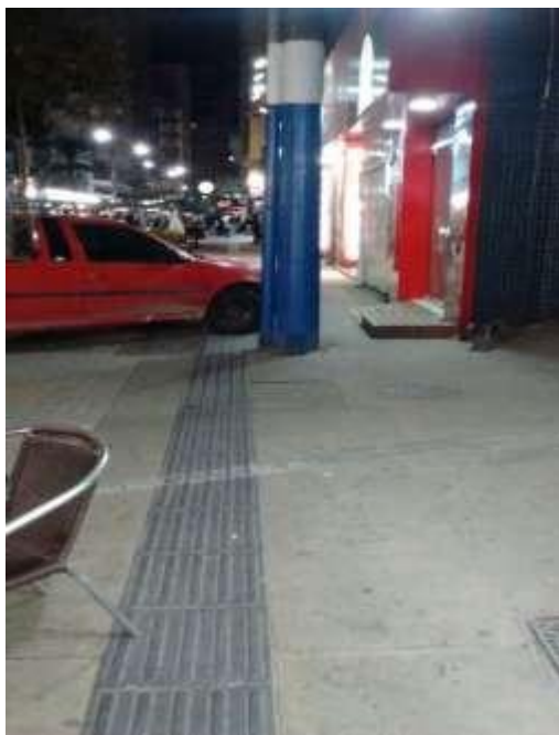
Figura 15: Obstrução de Piso Tátil por Veículo.
