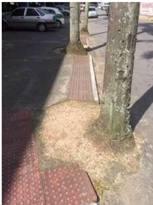
Figura 13: Piso Tátil colocado na Faixa de Serviço da Calçada.
