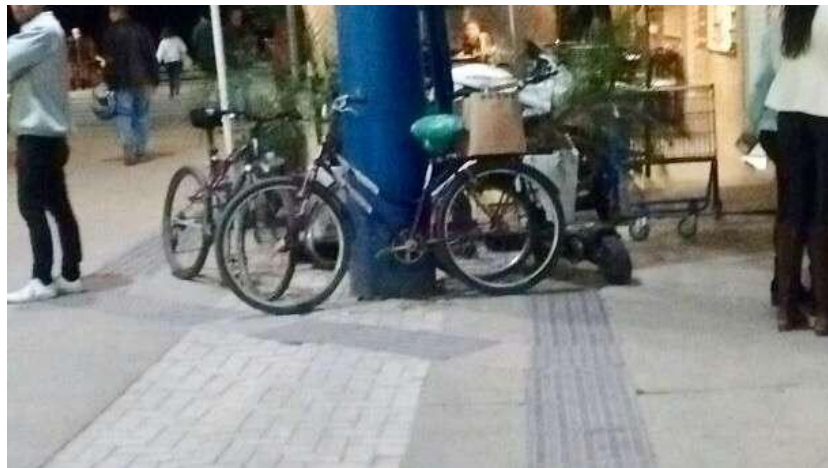
Figura 12: Piso Tátil Desconexo e com Obstáculos.
