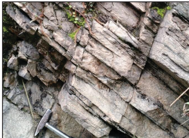
FIGURA 53 - TALUDE DE GNAISSE NO PONTO SA-4.
