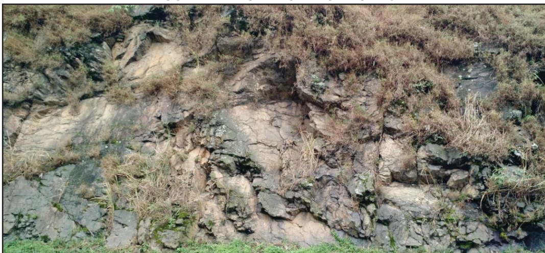
FIGURA 71 - VISTA DO TALUDE SA-10.
