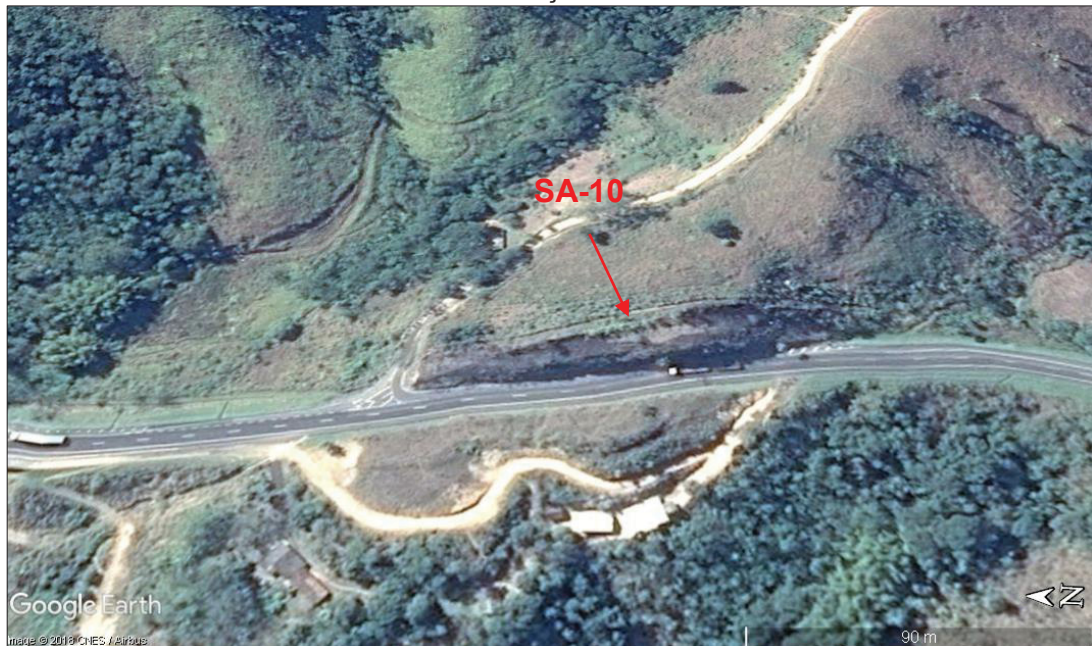
FIGURA 70 - LOCALIZAÇÃO DO TALUDE SA-10.
