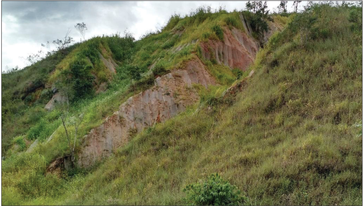
FIGURA 24 - CICATRIZ EM MATERIAL COLUVIONAR NO KM 518+100.
