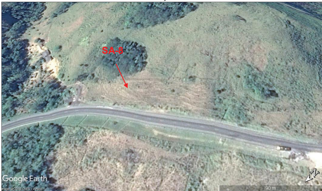
FIGURA 66 - LOCALIZAÇÃO DO TALUDE SA-8.
