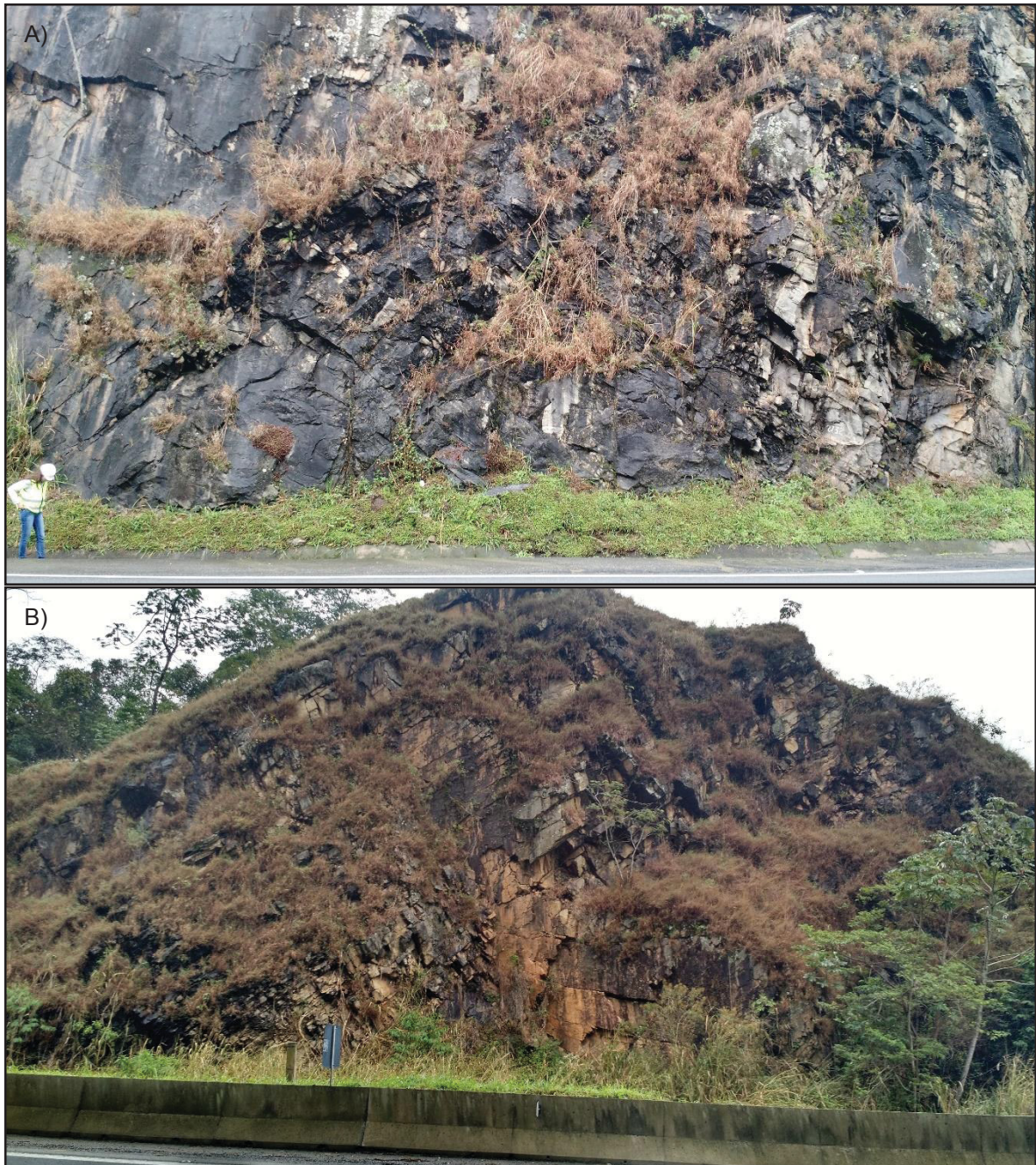
FIGURA 57 - TALUDES NO PONTO SA-5. A) FACE VOLTADA PARA SW, B) FACE VOLTADA PARA NE.
