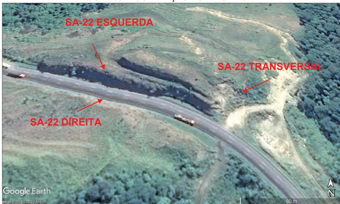
FIGURA 83 - LOCALIZAÇÃO DO TALUDE SA-22.
