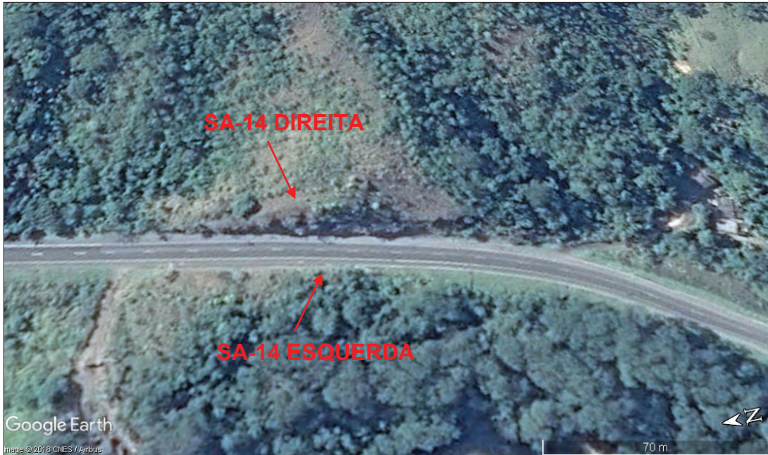
FIGURA 78 - LOCALIZAÇÃO DO TALUDE SA-14.
