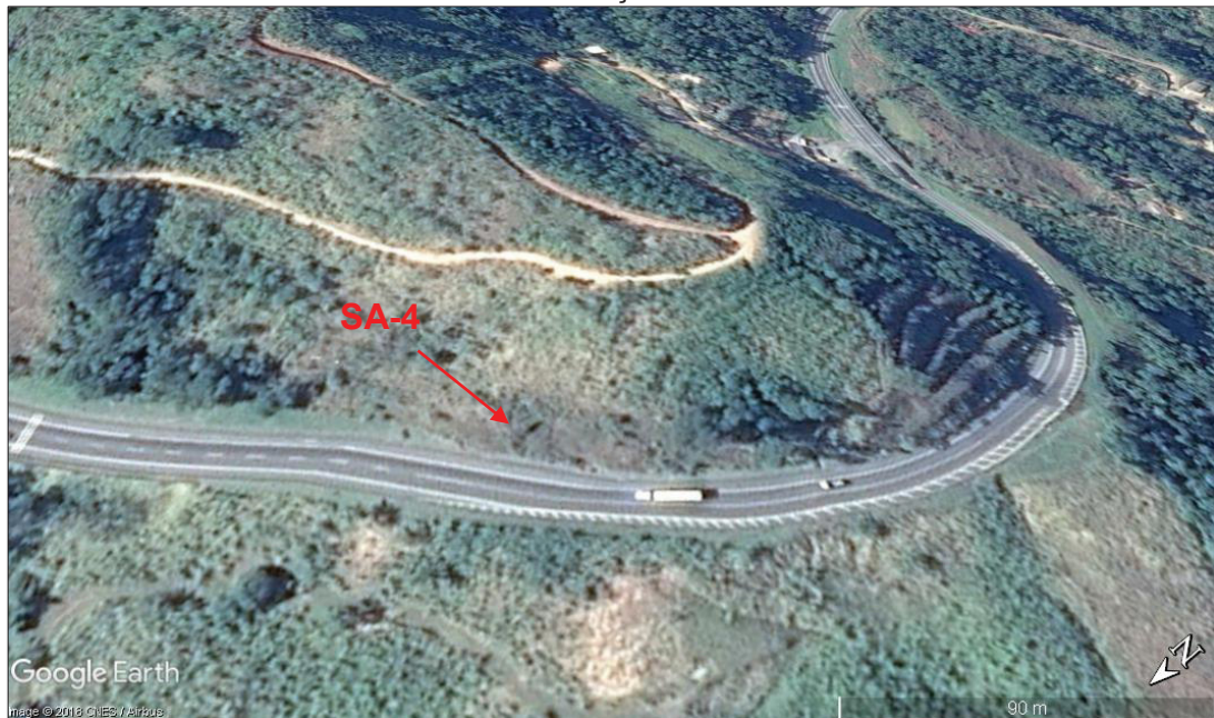
FIGURA 52 - LOCALIZAÇÃO DO TALUDE SA-4.
