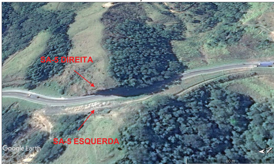
FIGURA 56 - LOCALIZAÇÃO DO TALUDE SA-5.
