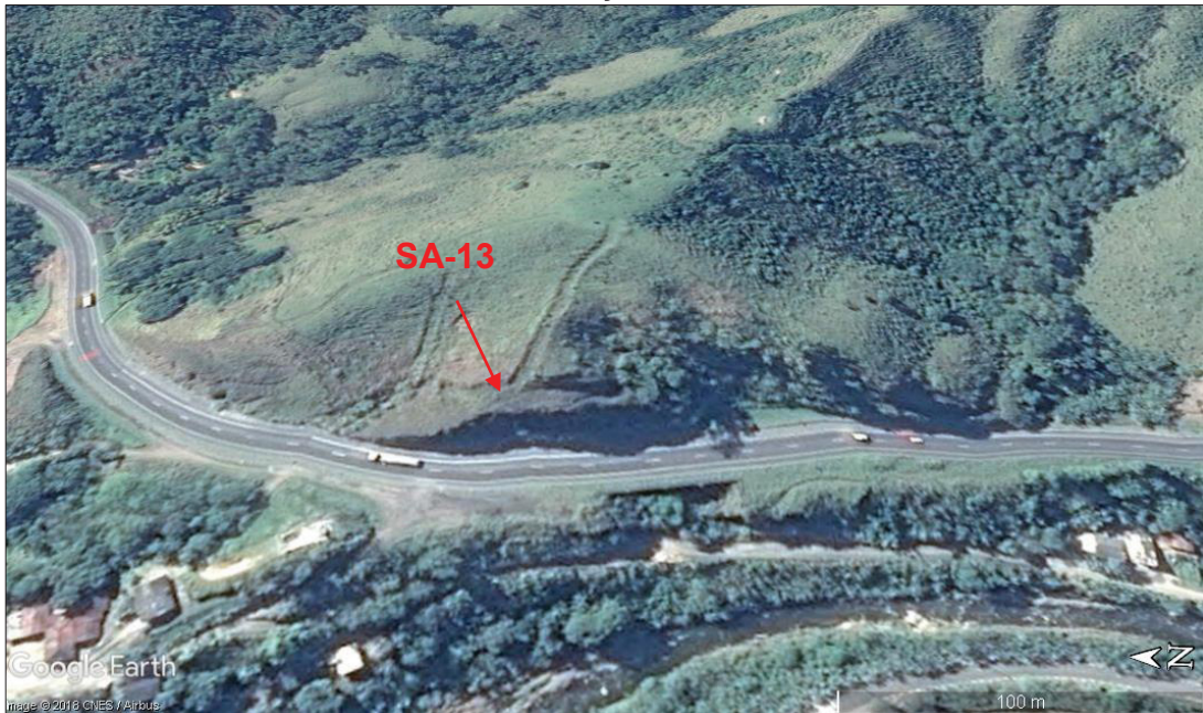
FIGURA 74 - LOCALIZAÇÃO DO TALUDE SA-13.
