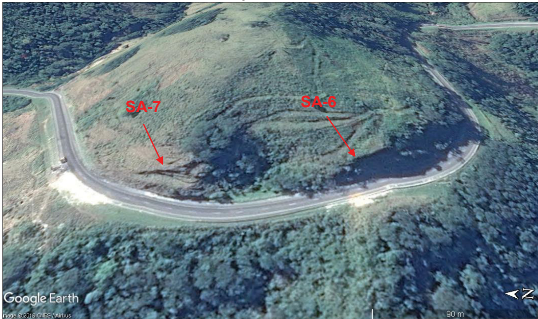
FIGURA 61 - LOCALIZAÇÃO DOS TALUDES SA-6 E SA-7.
