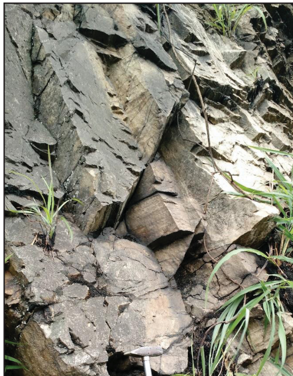
FIGURA 62 - DETALHE DO TALUDE SA-7.
