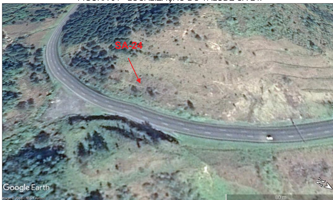
FIGURA 91 - LOCALIZAÇÃO DO TALUDE SA-24.
