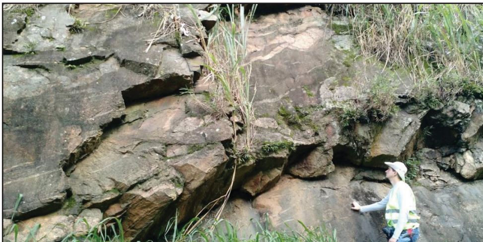
FIGURA 79 - VISTA DO TALUDE COMPOSTO POR GRANITO GNAISSE.
