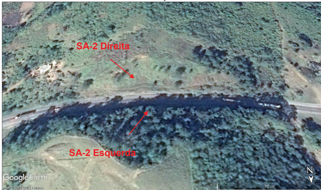
FIGURA 47 - LOCALIZAÇÃO DO TALUDE SA-2.
