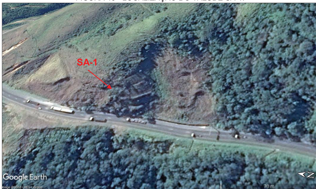
FIGURA 43 - LOCALIZAÇÃO DO TALUDE SA-1.
