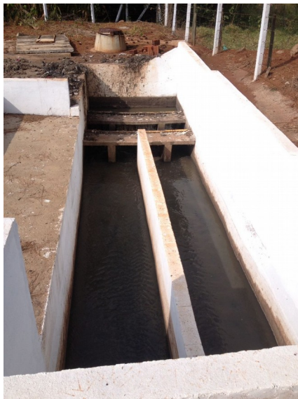
Figura 17 - Ponto de entrada do sistema de lagoas, onde se aplicou a biomassa
