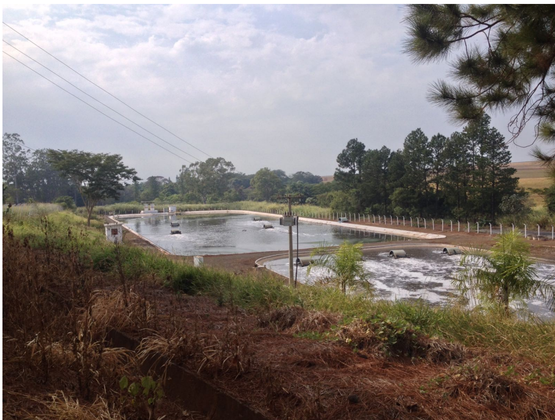
Figura 15 – Local das instalações da ETE por lagoas
