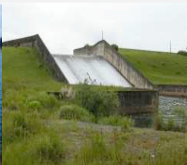
Represa do Pasaúna Barragem do Vertedouro – 2014
