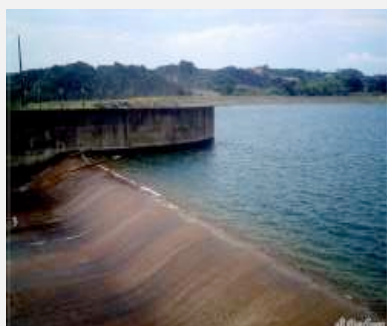
Represa do Passaúna Base do Vertedouro – 2014
