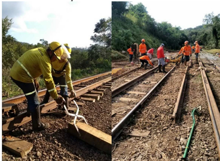
FOTO 03 - SUBSTITUIÇÃO DE DORMENTES E TRILHOS - LMR-LSQ
