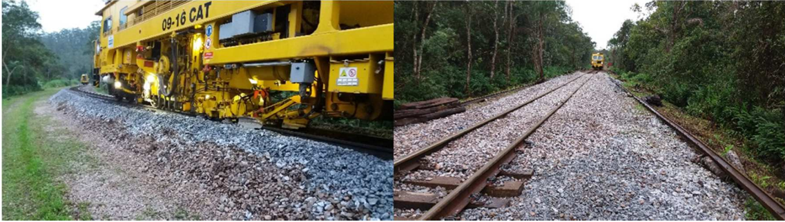
FOTO 02 - SUBSTITUIÇÃO DE LASTRO E SOCARIA - LMR-LSQ
