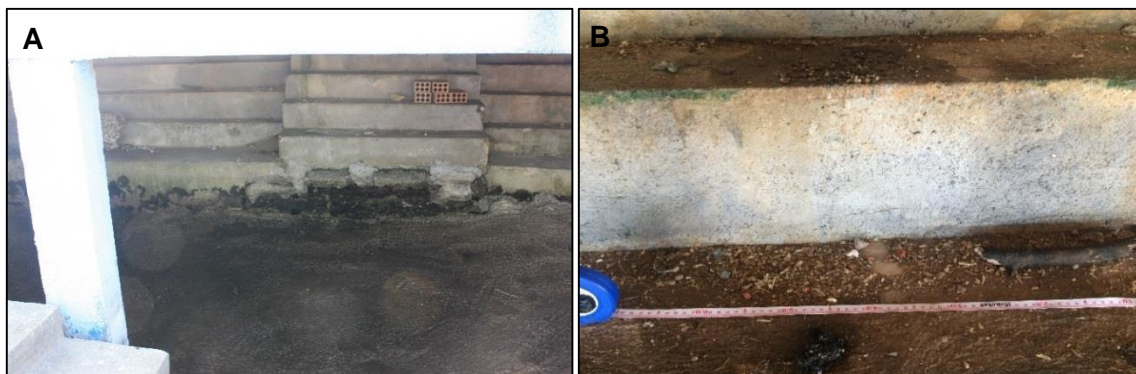
FIGURA 09: A- ESCADA LOCALIZADA SOB O PÁTIO DE UMA MARINA (ÁREA INUNDÁVEL), NO CANAL DO DNOS, B- REGISTROS DE MARCAS ODORÍFERAS DEPOSITADAS POR L. longicaudis NO LOCAL. FONTE: A autora (2014).
