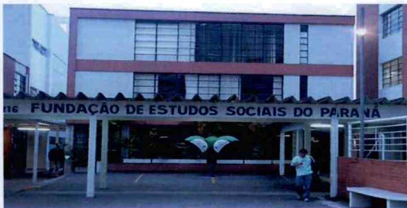
Primeiro Prédio – Rua General Carneiro, 216
