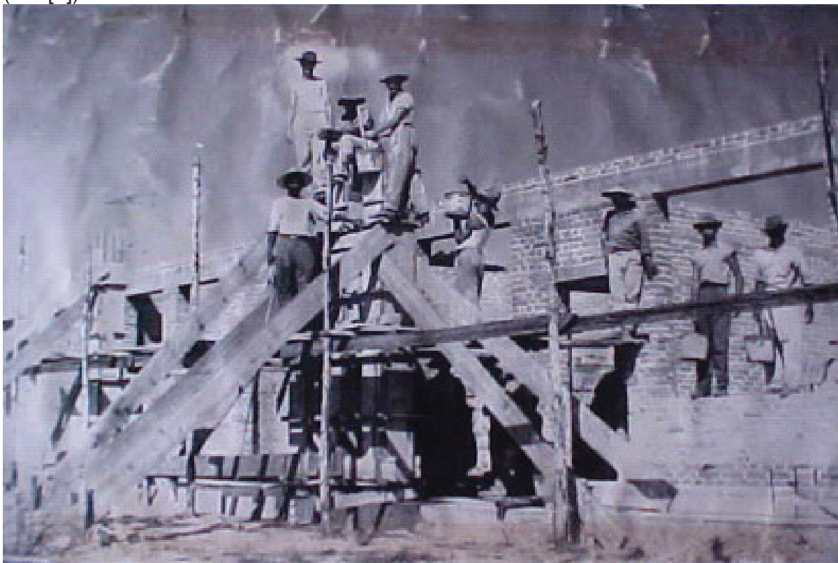
FIGURA 5 – OPERÁRIOS TRABALHANDO NA OBRA DA ESCOLA AGRÍCOLA. (195[?]).
