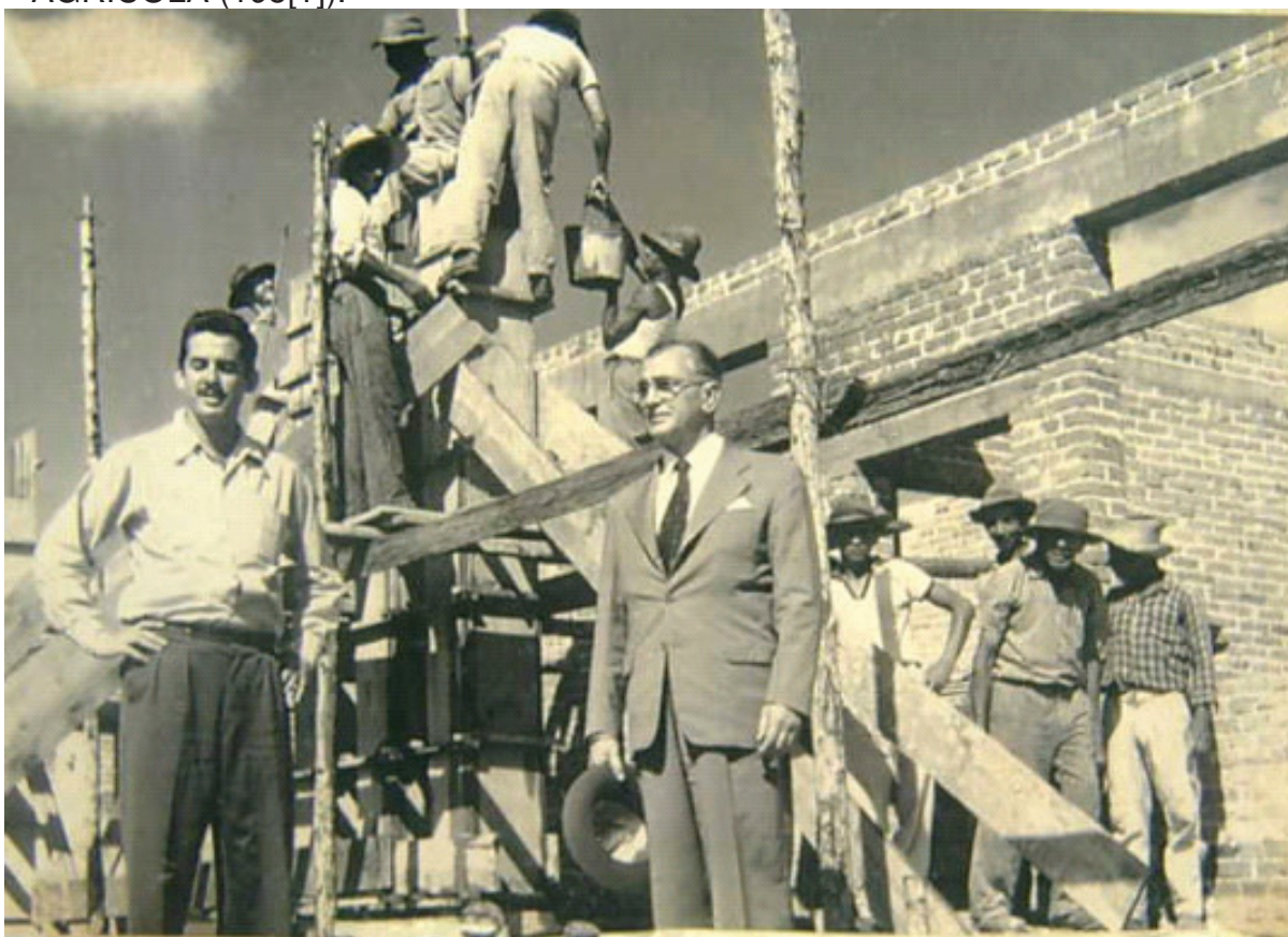
FIGURA 6 - SENADOR CARLOS GOMES DE OLIVEIRA E O DIRETOR BENJAMIM FERREIRA GOMES VISTORIANDO AS OBRAS DA ESCOLA AGRÍCOLA (195[?]).
