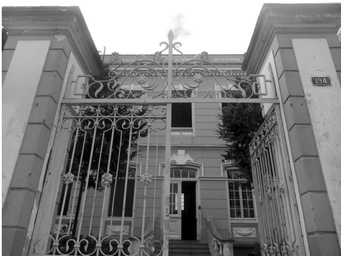
Detalhe do Segundo Edifício do Colégio Regente Feijó, 2017. Foto da Autora.
